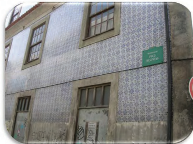
Figura 5 - Travessa do Poço das Patas
