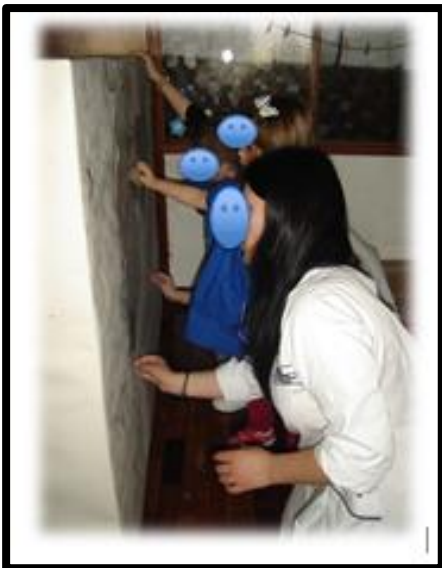
Anexo nº 2.20a – Pintura de paredes do novo cantinho.
