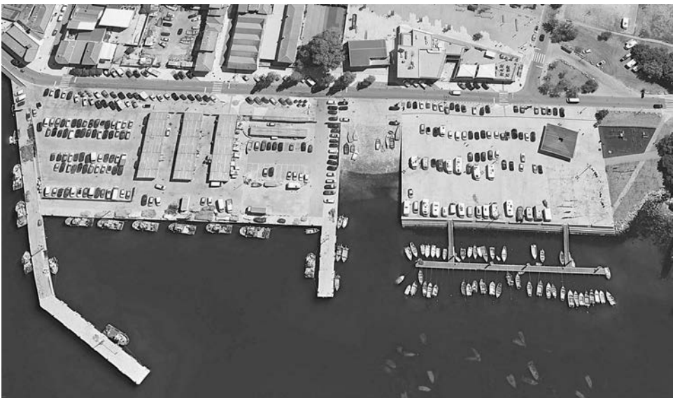
Figura 5.4 Plataforma de pesca, estacionamentos e parque infantil: após intervenção do Programa Pólis
