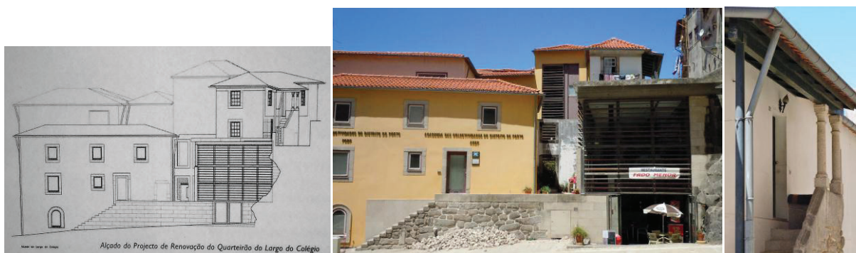
Imagem 36 - Porto – Zona da Sé - Intervenção no Largo do Colégio
