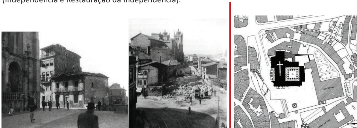
Imagem 42 - Demolição do casario em torno da Sé. Fonte: Revista Monumentos nº 14:77
